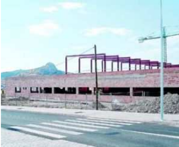
Aspecto que ofrecían ayer las obras del hospital de Peñarroya. Foto: Y.G.
