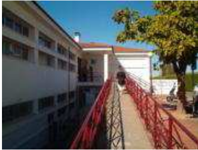
R.G.N. El centro de salud limita futuras ampliaciones
