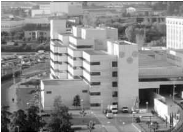
Panorámica del exterior del hospital universitario Reina Sofía. Foto:A.J. GONZALEZ
